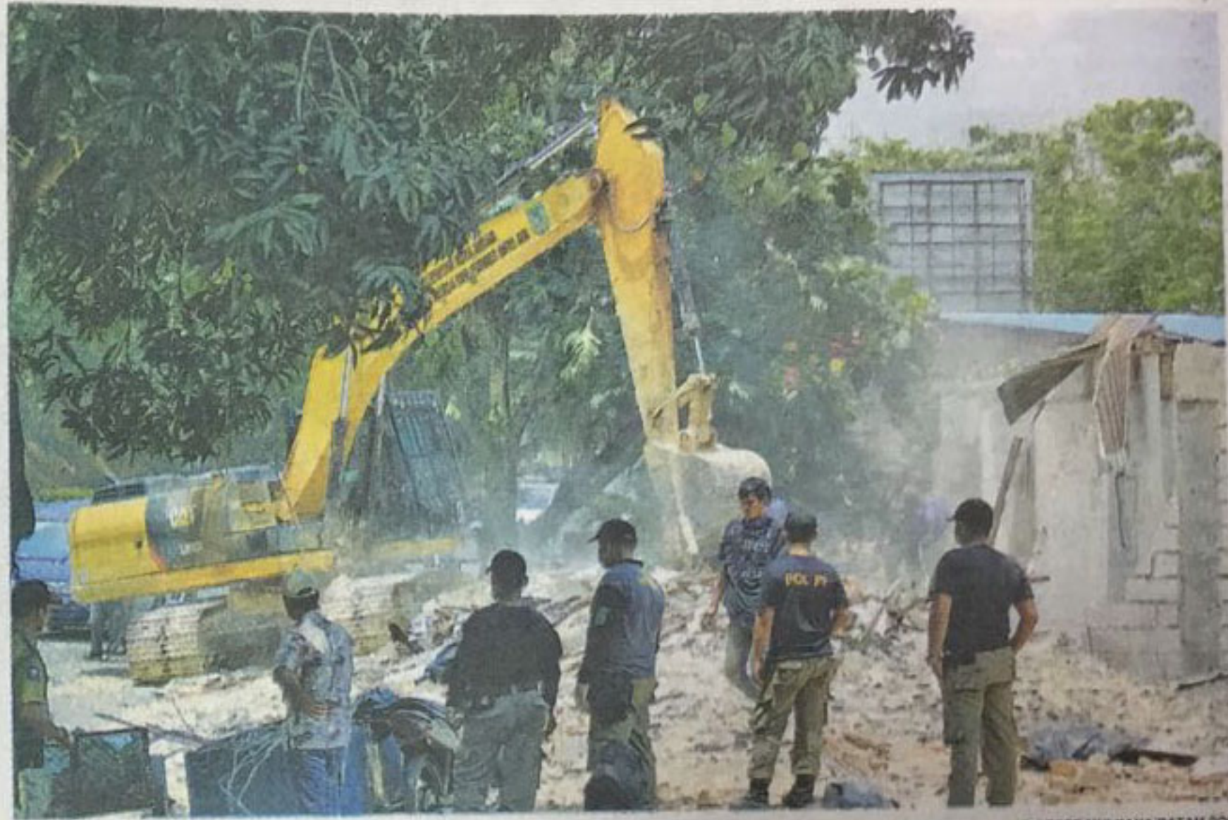
TIM Terpadu membongkar bangunan yang ada di pinggir jalan di sekitar Simpang Baloi Center, Lubukbaja, Kamis (12/4). Penertiban ini akan dilanjutkan dengan pelebaran ruas jalan di kawasan tersebut.
