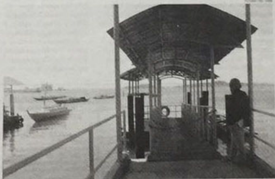
PONTON kapal Pelabuhan pengumpan Sekupang-Belakang Padang, telah dirampungkan Dinas Perhubungan (Dishub) Kota Batam.
